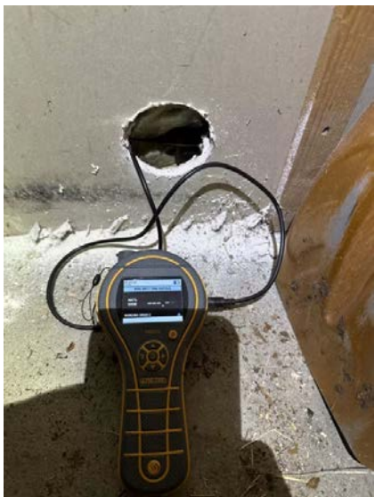
Det er foretatt hulltaking med 73 mm hullbor fra tilstøtende rom (gang).
