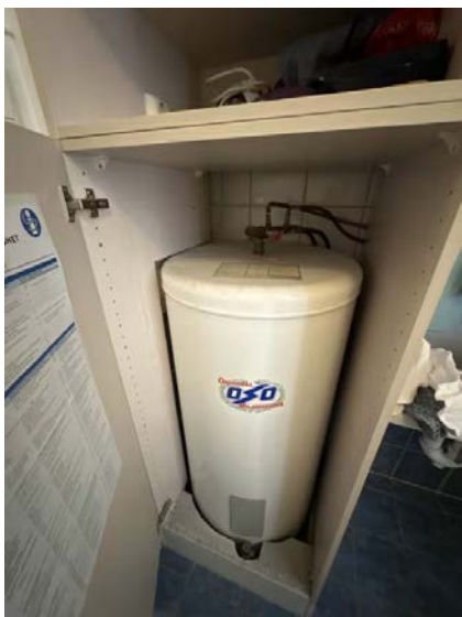
Viser bereder plassert på bad i 1.etasje
