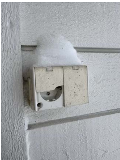
Defekt deksel på utestikk.
