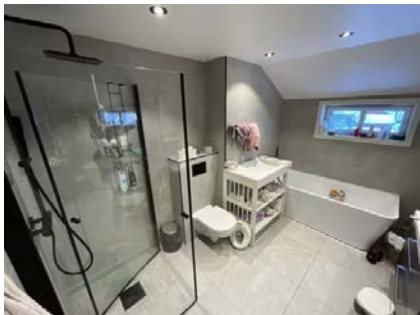
Viser innfellbare dusjdører, veggmontert termostatbatteri, dusjgarnityr, badekar, veggmontert toalett med innebygget sisterner.
