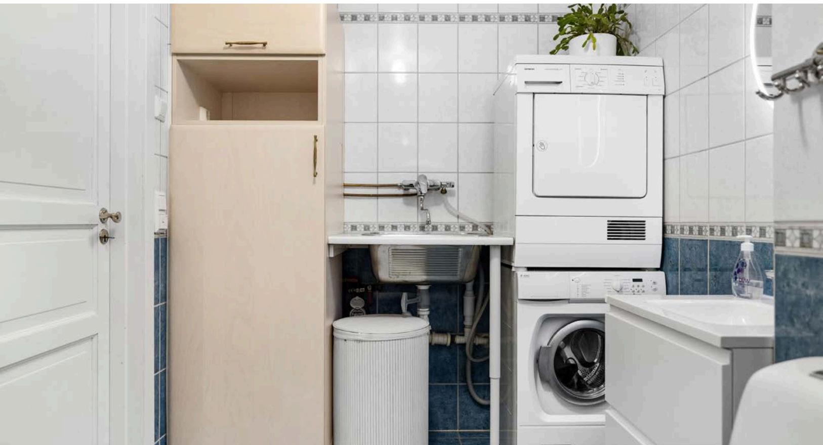
Praktisk vaskerom-sone med utslagskum, opplegg for både vaskemaskin og tørketrommel, samt skap med varmtvannsbereider. Baderommet har fliser på gulv og vegger, deilig gulvvarme og mekanisk fuktstyrt vifte.
