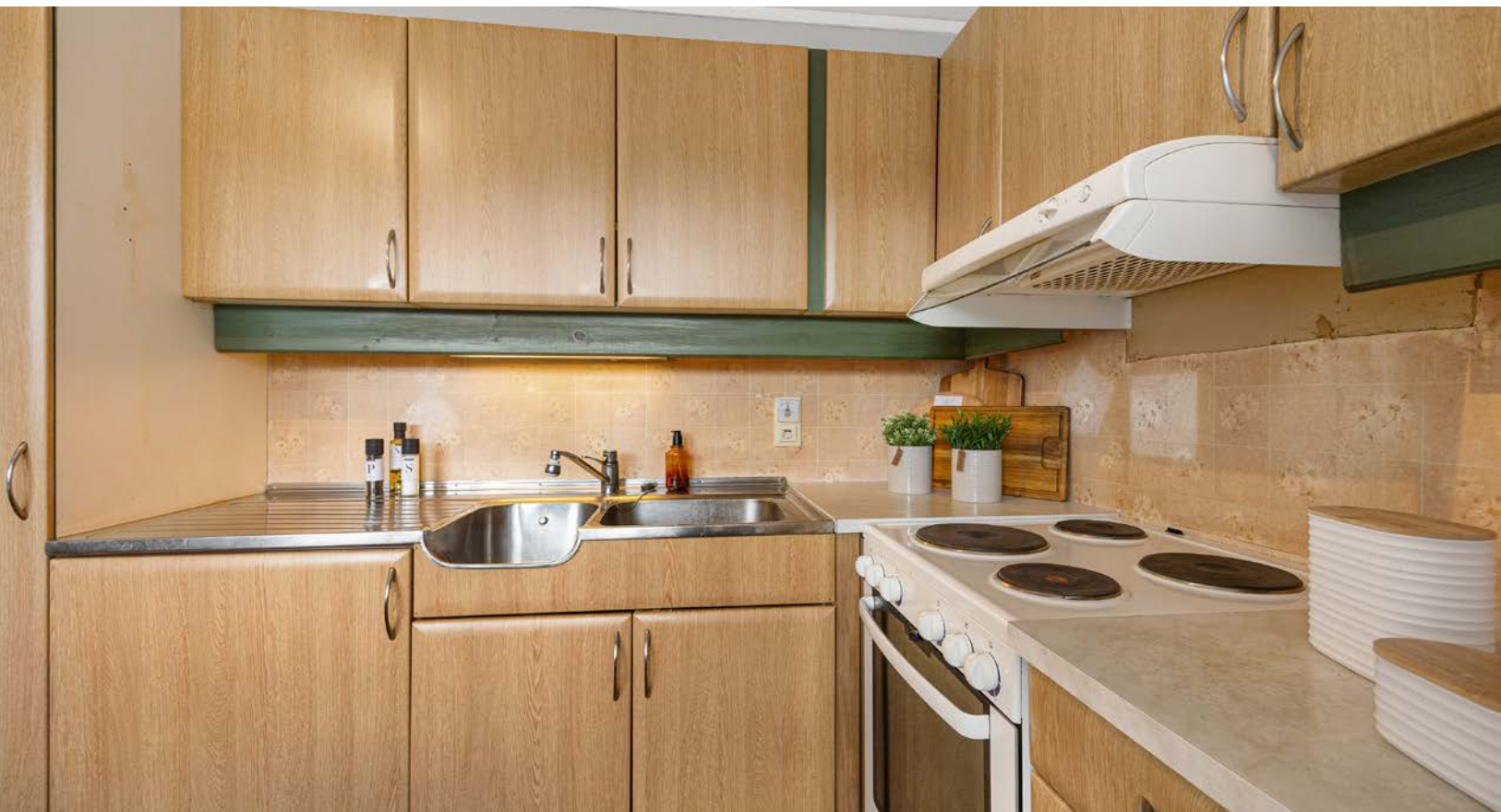
Innredningen er vinkelformet og har slette, trefolierte fronter, samt laminatbenkeplate og oppvaskbenk med heldekkende stålbeslag.
