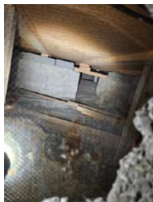
Krypkjeller sett igjennom ventil fra matkjeller.
