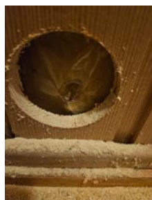
Måling av relativ luftfuktighet i lukket veggkonstruksjon mellom bod og bad. Måling av trefukt i lukket veggkonstruksjon mellom bod og bad.
