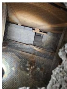
Krypkjeller sett igjennom ventil fra matkjeller.
