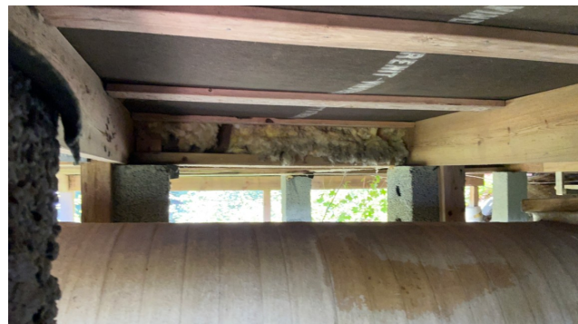
Åpent inn i isolasjon
