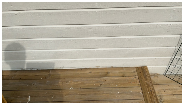
Terrasse bygget utpå kledning
