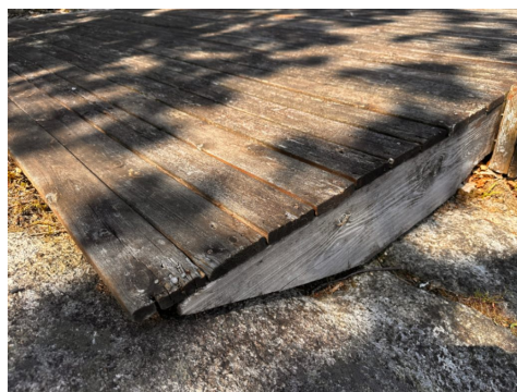
Slitt platting i terreng over hytten
