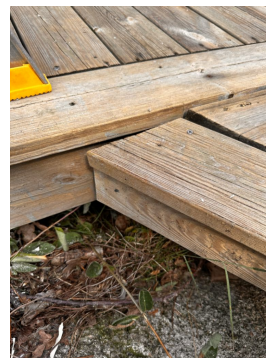
Slitt platting i terreng over hytten
