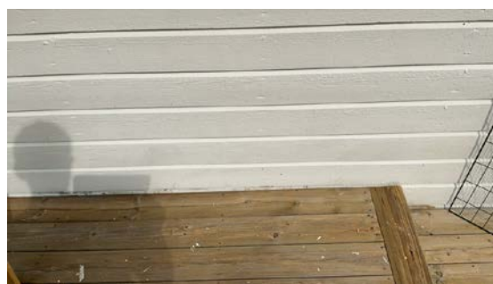
Terrasse bygget utpå kledning
