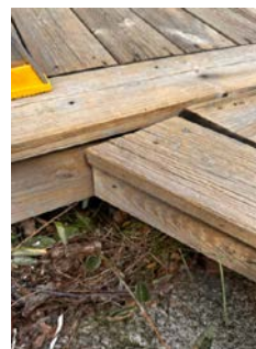
Slitt platting i terreng over hytten
