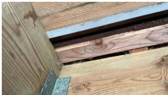
Det er ingen eller liten lufting i nedre kant av kledning mot grunnmur.
