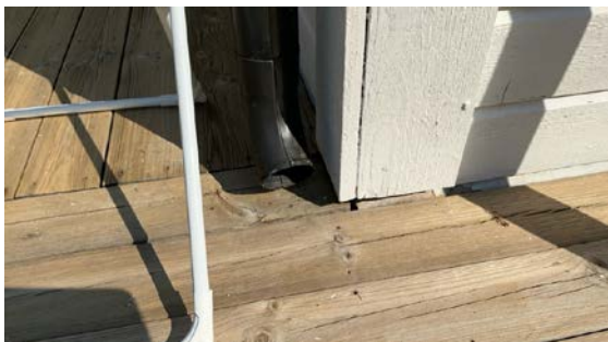
Nedløp bør føres ned under altan og bort fra søylepunkt.
