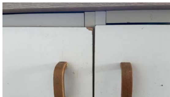
Skade på dør
