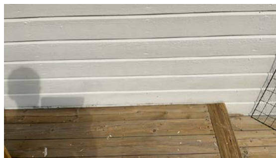
Terrasse bygget utpå kledning
