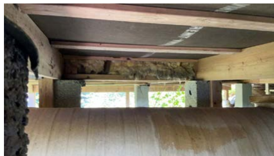
Åpent inn i isolasjon
