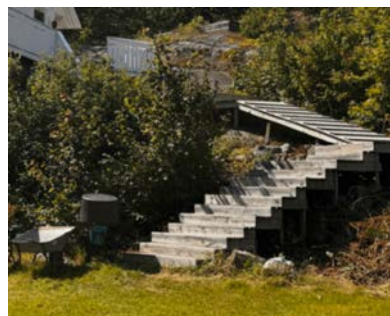
Mangler rekkverk
