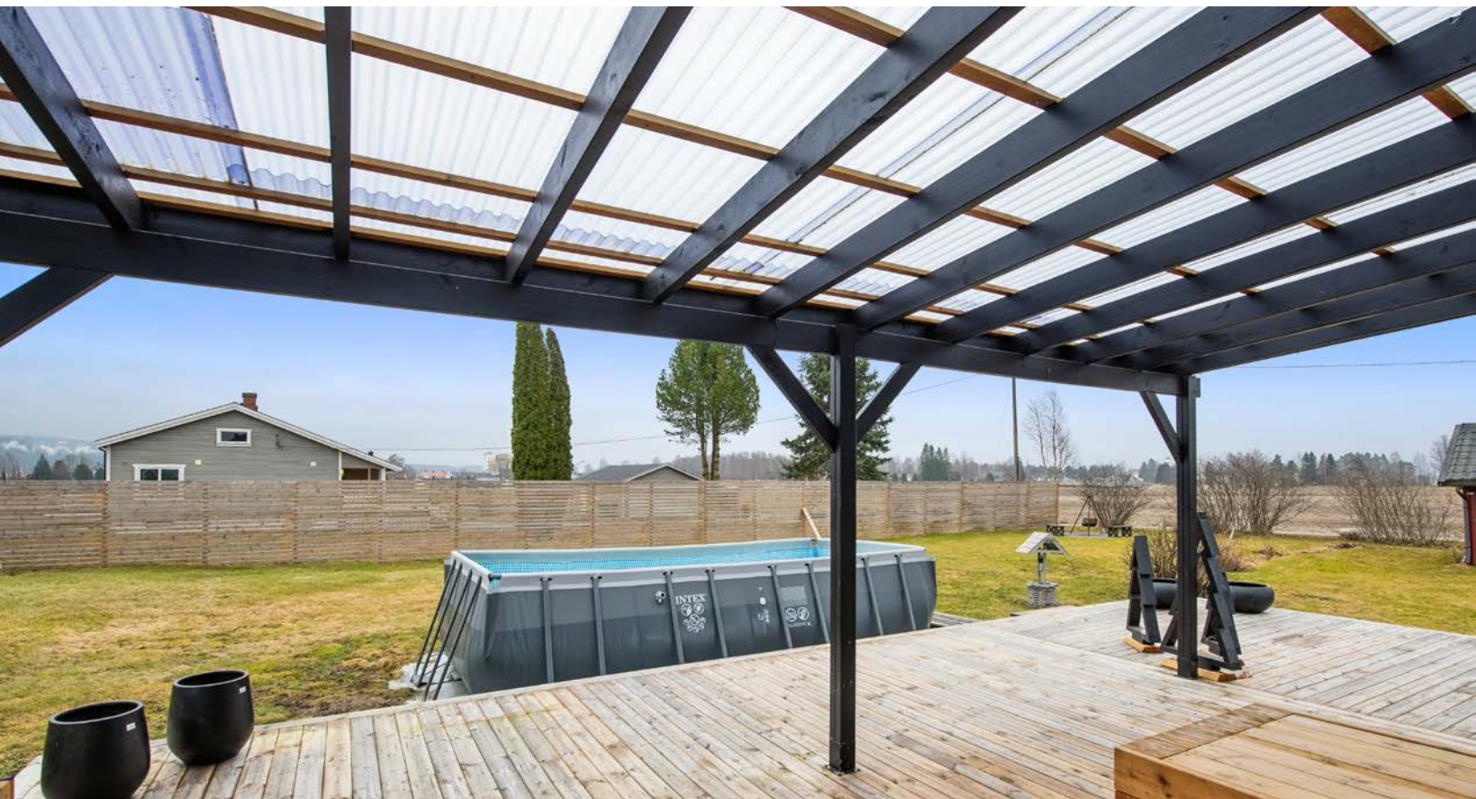
Terrassen har tak tekket med gjennomsiktige bølgetakplater.
