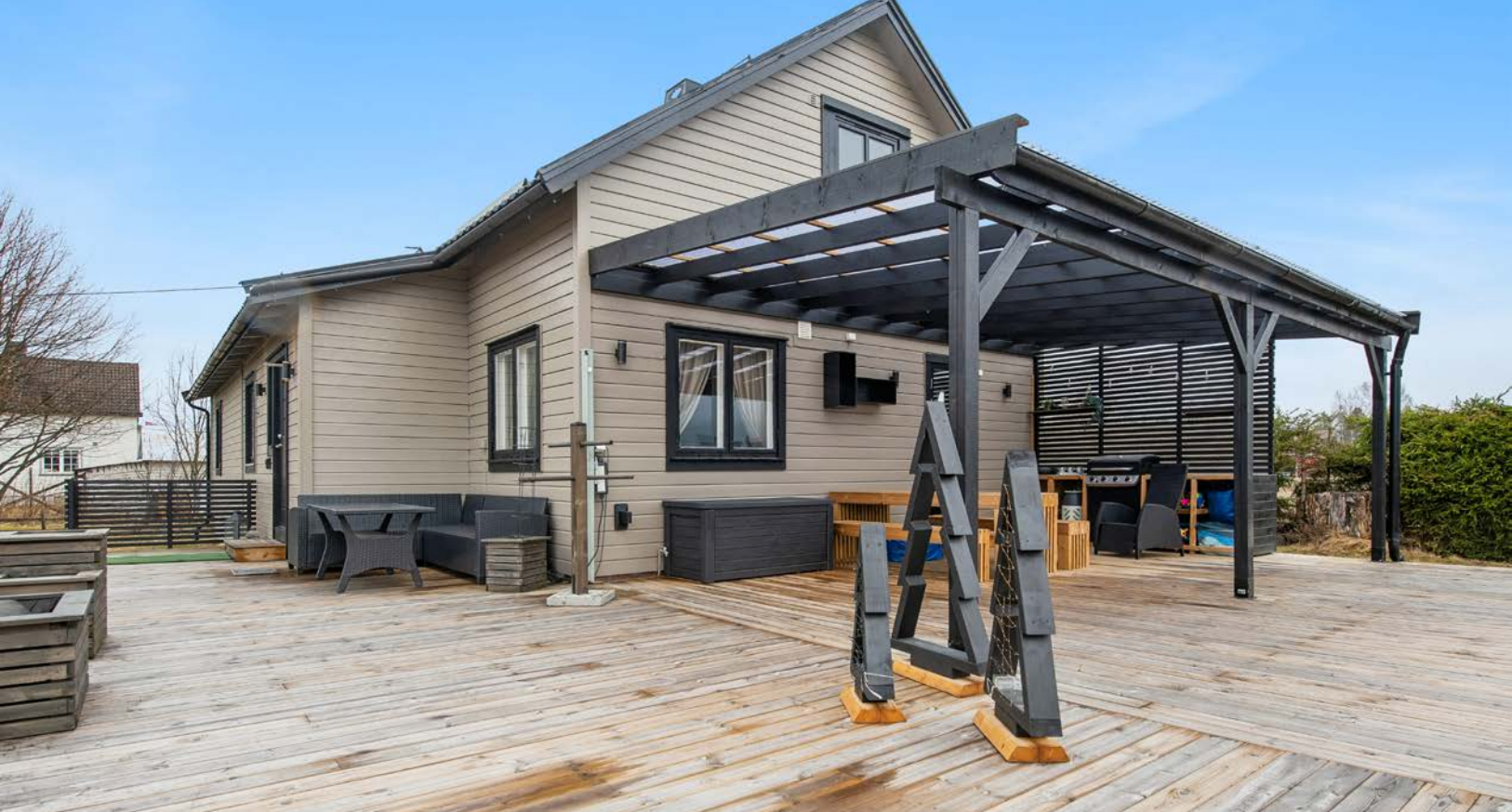
Utenfor er en ny og romslig terrasse.
