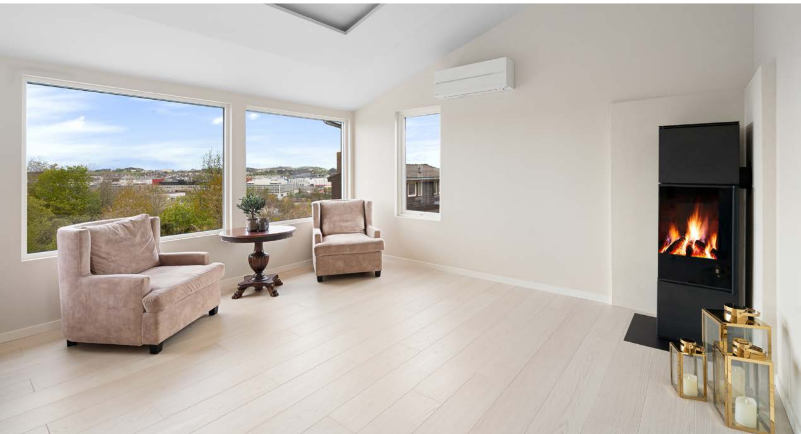
Vedovn og varmepumpe montert
