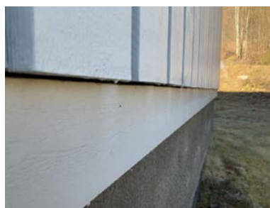
Ingen dryppkant forkorter kledningens funksjonstid. Det anbefales å etablere skråskjære nedre del av kledningen for å begrense fuktopptrekk i treverket. Viktig at endedved overflatebehandles.
