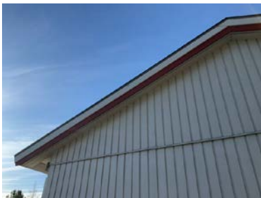
Vindskier bærer preg av elde og slitasje.
