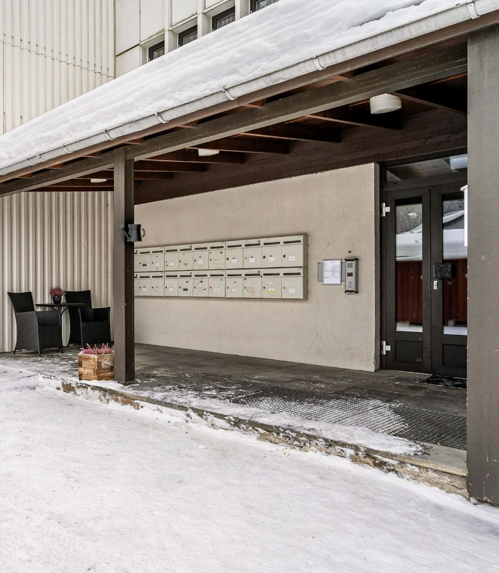
Borettslagets overbygde inngangsparti. I tillegg er det en felles bod for hver etasje, i bygget foran blokka. Her kan sykler, sparker, kjelker og ski plasseres.
