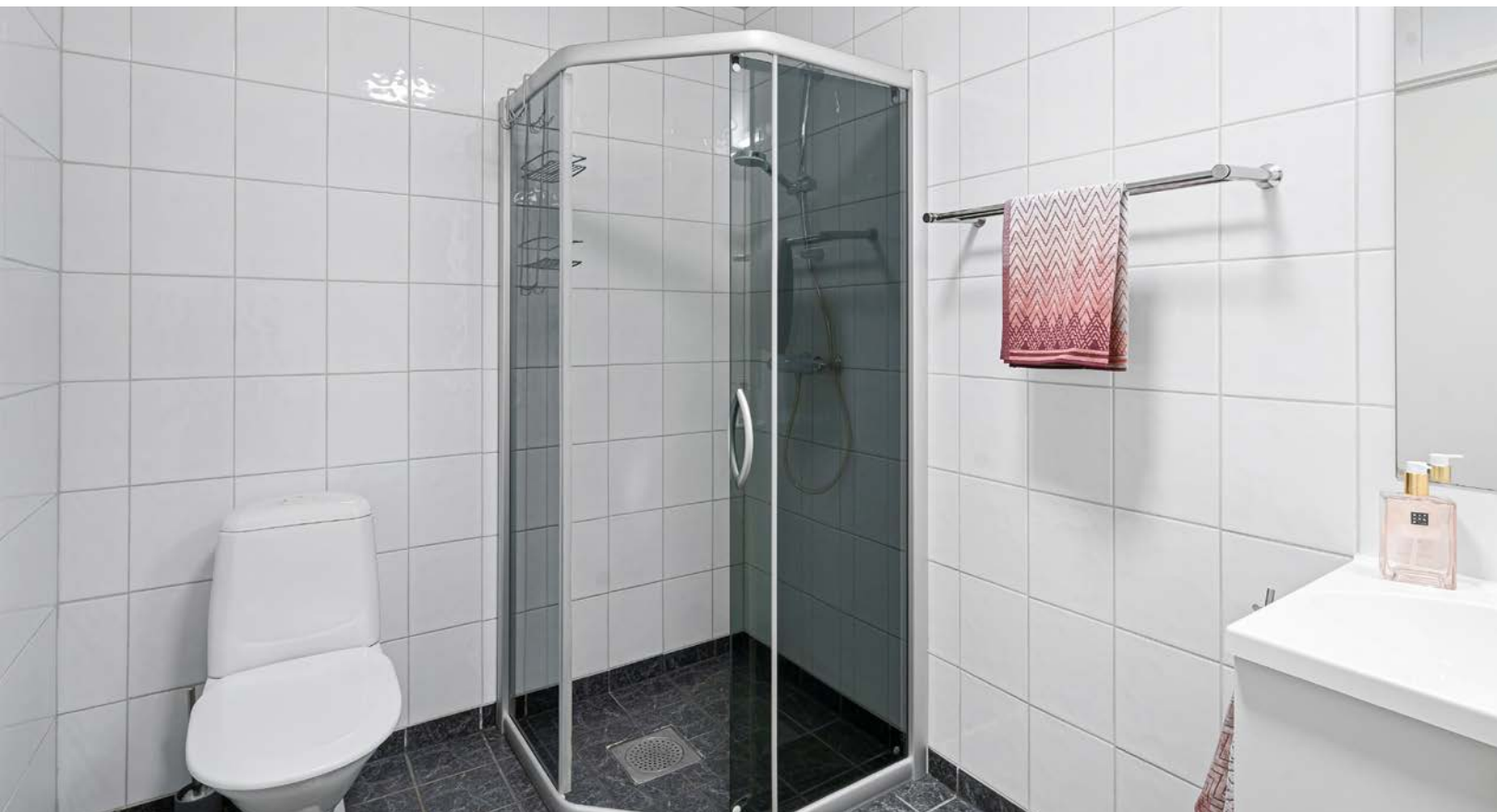
Hjørnedusj ved siden av toalettet.
