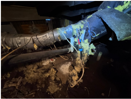
Stoppekransen er plassert utvendig under boligen.
