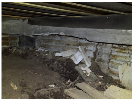
Skadet betongdrager.
