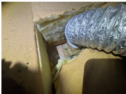
Punktering av dampsperran.
