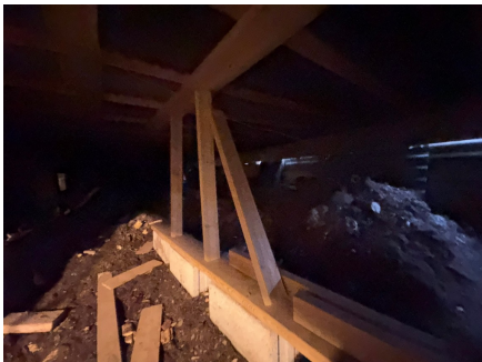
Provisorisk understøtte av bjelkelaget.
