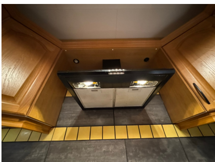
Manglende deksel framfor lysene.
