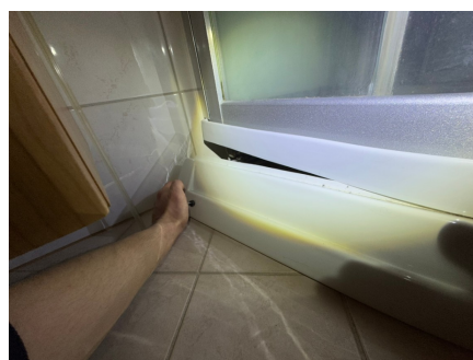
Ikke mulig å ta av sokkelen på dusjkabinettet.
