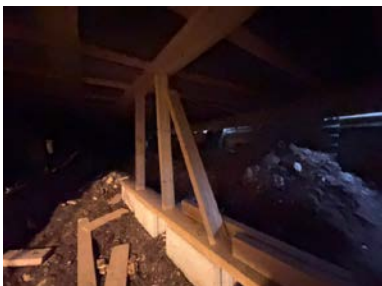
Provisorisk understøtte av bjelkelaget.
