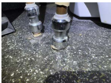
Utette rørgjennomføringer.
