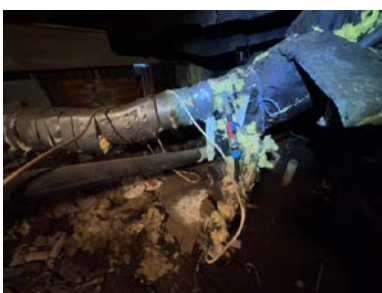
Stoppekranen er plassert utvendig under boligen.
