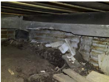
Skadet betongdrager.
