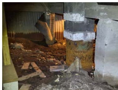
Lavere terreng under boligen en utenfor boligen.
