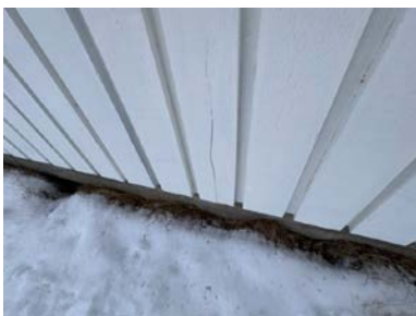
Eksempel på spekk i kledningen.
