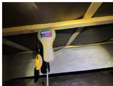
Fuktmåling i lekter i krypekjelleren.
