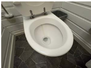
Merker i toalettskålen etter lekkasje på sisternen.
