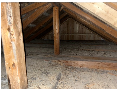
Etasjeskille isolert med leire.
