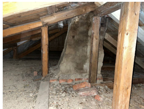
Eldre pipe på møneloft, som er utbedret over tak.
