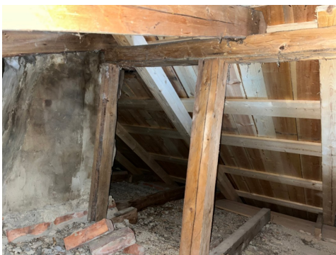
Deler av takkonstruksjon er utbedret.
