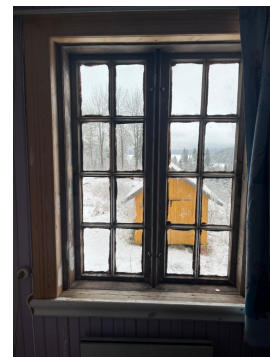
Pågående restaurering/maling av vindu.
