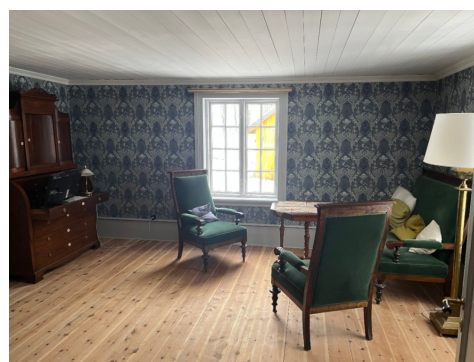
Stue med nytt tregulv og håndtrykt tapet.
