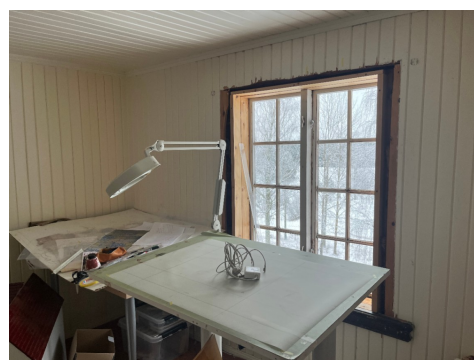
Gjenstående arbeider i loftetasje.
