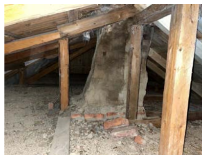
Eldre pipe på møneloft, som er utbedret over tak.
