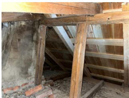
Deler av takkonstruksjon er utbedret.
