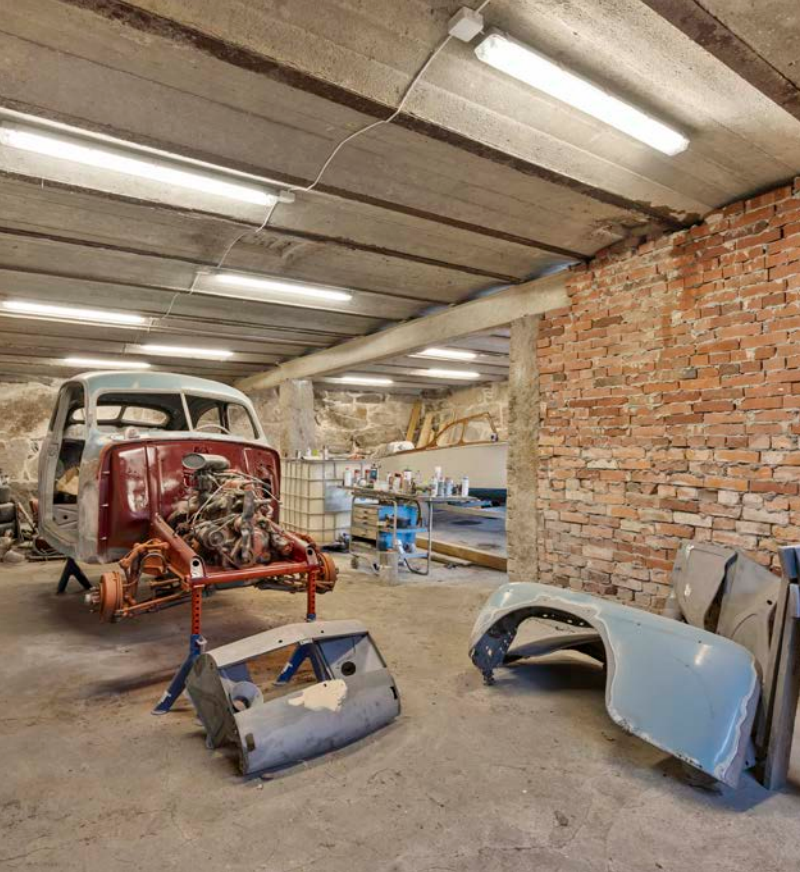
Det opprinnelig kufjaset er i delen med teglsteinsmur.
