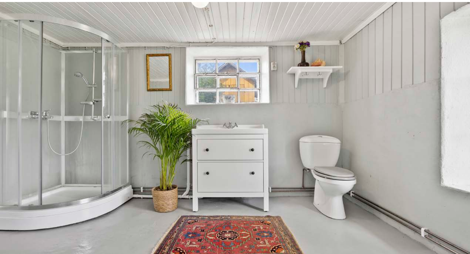
Rommet har nyere røropplegg, malt betonggulv med sluk, hvitmalt paneltak og en kombinasjon av malt brystningspanel og mur på veggene. Kjellervinduer på to sider, begge med jernbindere, tilfører sjarm og dagslys.
