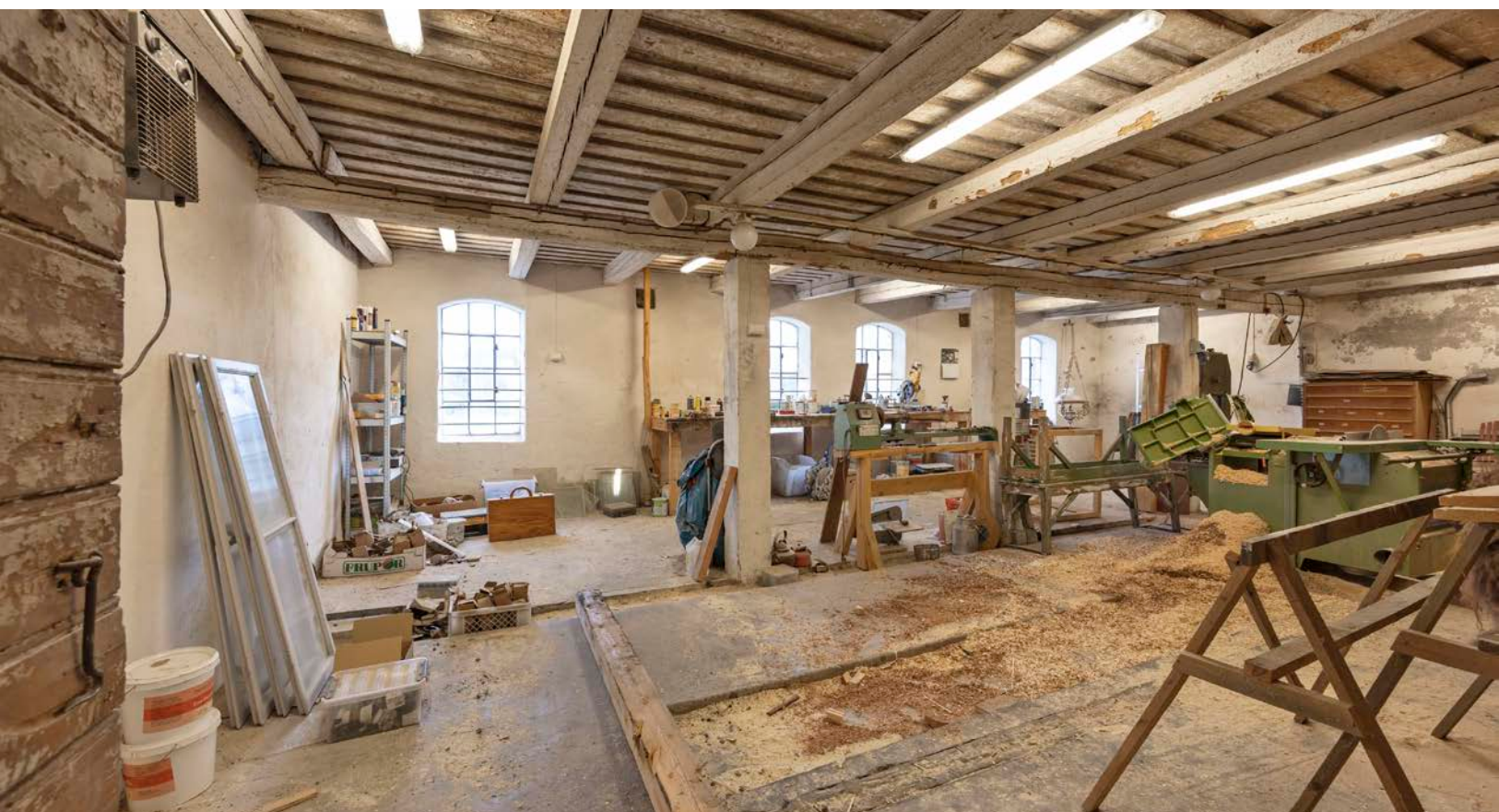
Her er det nå innredet med lyse, luftige verkstedslokaler med både kombimaskin og båndsag.
