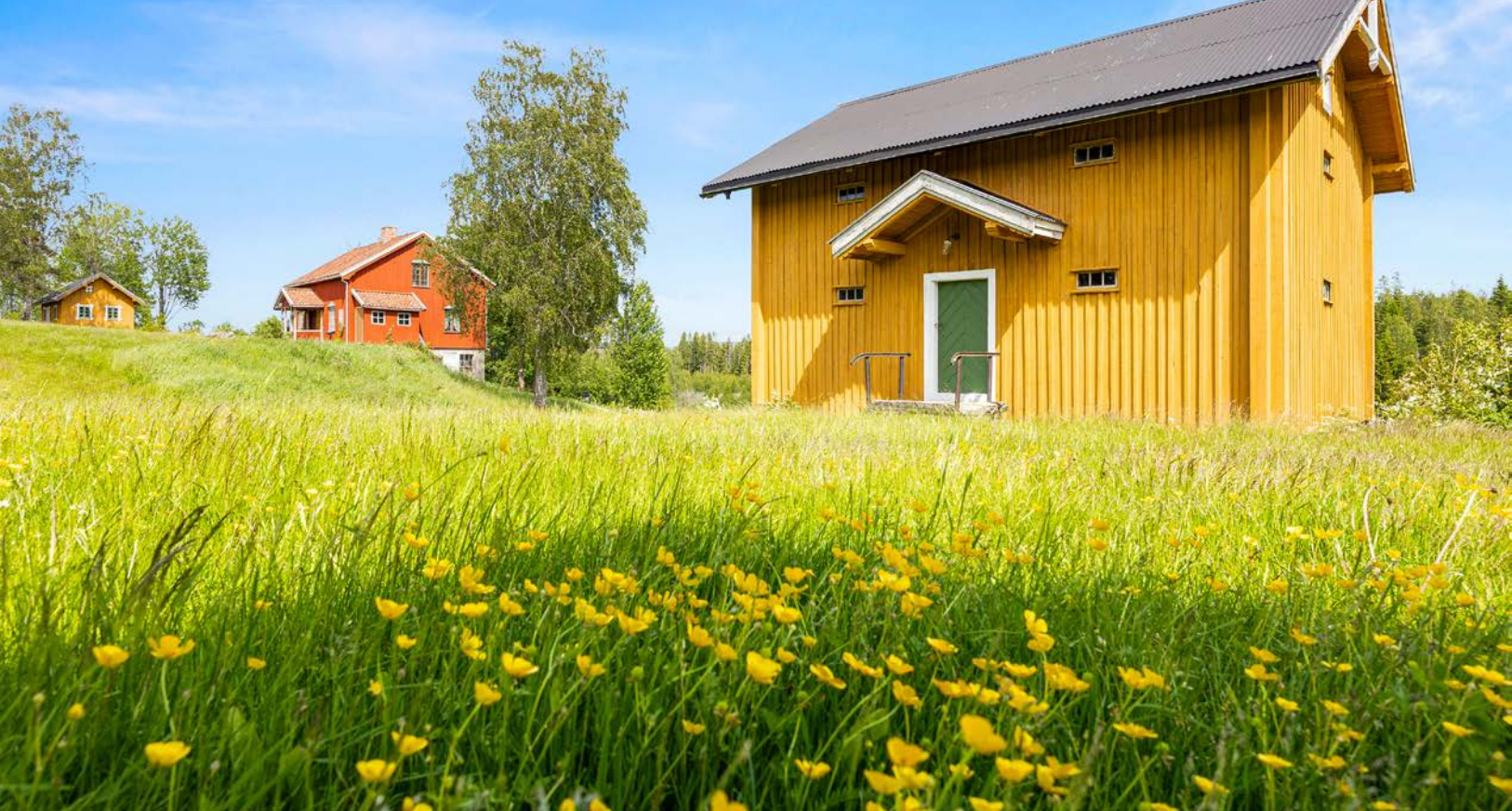
Stabburet er oppført i laft, kledd i panel og har innlagt strøm.
