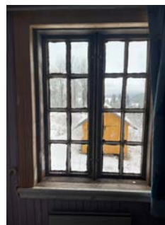
Pågående restaurering/maling av vindu.
