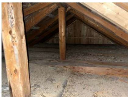
Etasjeskille isolert med leire.
