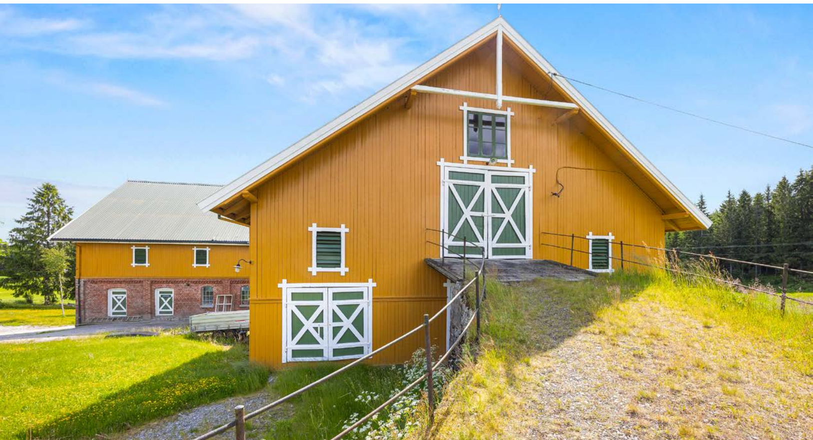
Bygget har takplater i stål fra 1967, panelkledning, mur i teglstein, bislag mot verkstedet og ei låvebru til loftet.
