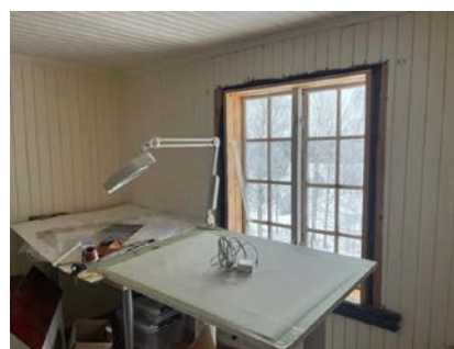
Gjenstående arbeider i loftetasje.
