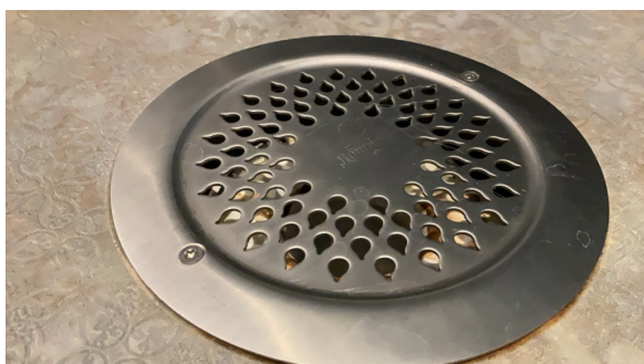
Kontroll av sluk.
