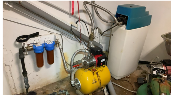
Vannpumpe og stoppekran plassert i kjeller.
