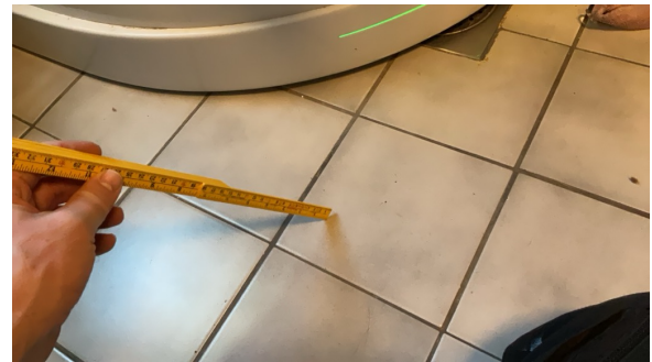
Bom/hullyd på fliser flere steder.
