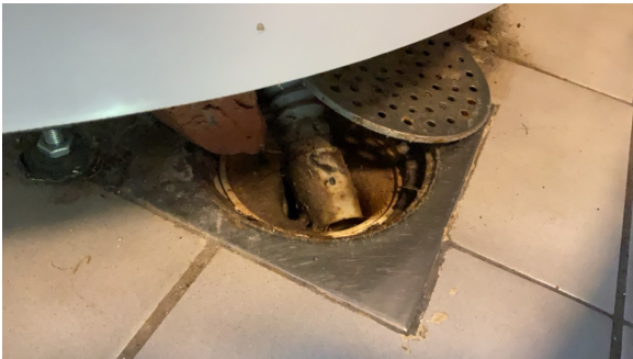
Kontroll av sluk.
