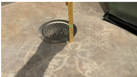
Målt fall til sluk: 30mm
