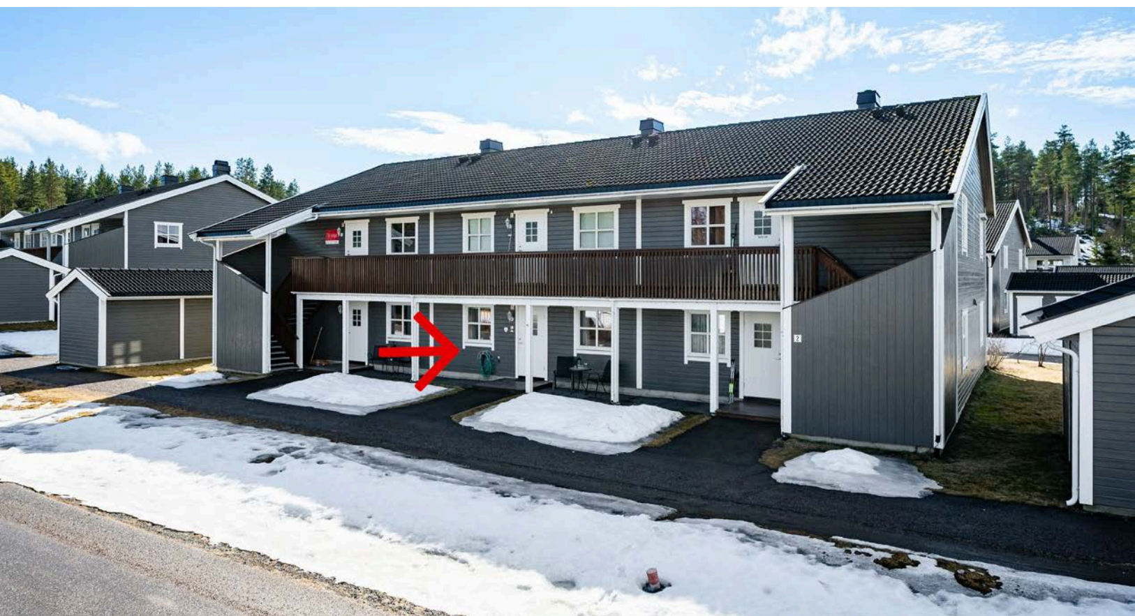
I tillegg disponerer leiligheten en egen bod på ca. 5m 2 i felles uthus, samt en parkeringsplass på ca. 14m 2 i felles carport-anlegg.
