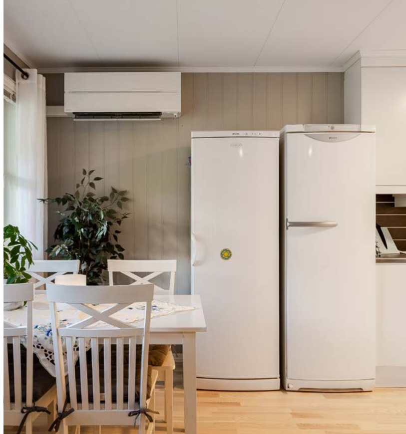
Det ble lagt nytt gulv på kjøkkenet i 2025 og det er åpne løsninger for hvitevarer.
