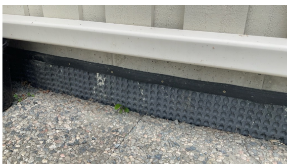
Synlig grunnmursplast på mur til påbygg fra 2009
