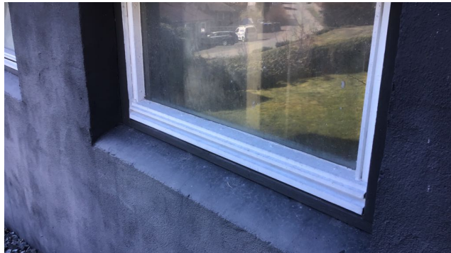
Vannbrett og stuevinduer med råteskader
