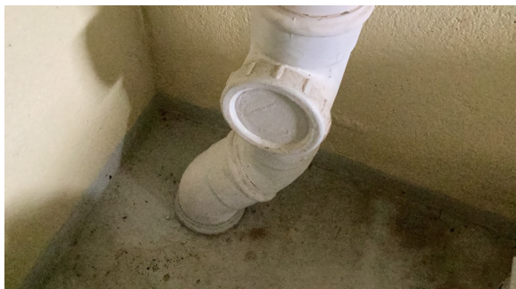
Stakepunkt i kjeller.
