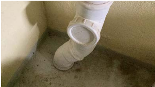
Stakepunkt i kjeller.
