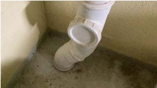
Stakepunkt i kjeller.
