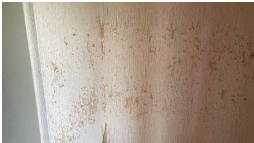
Eksempel på slitasje.
