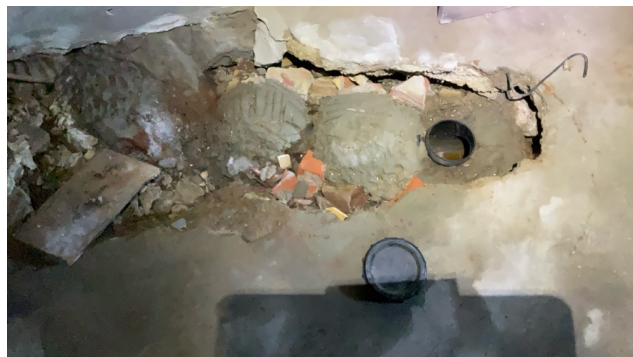
Plast i bunnledning under gulv i kjeller.
