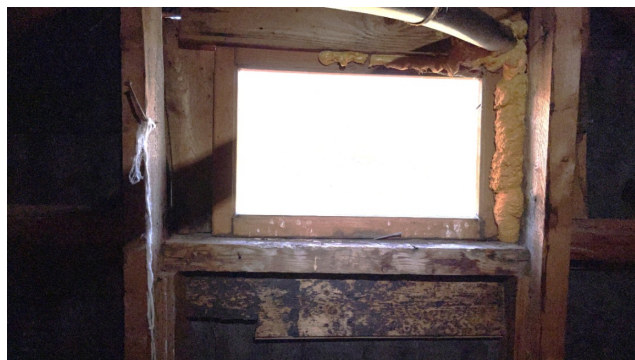
Vindu på kaldloft.
