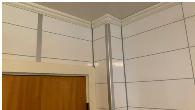
Innvendige hjørner er fuget.
