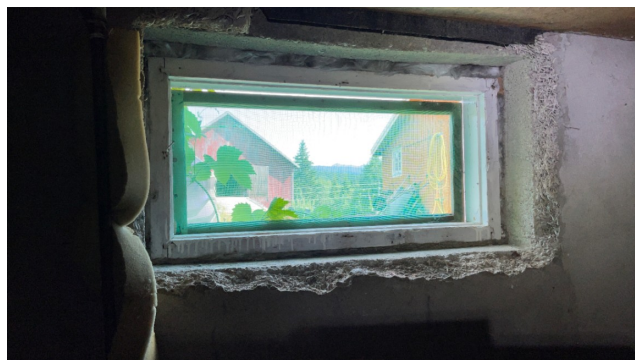
Vindu i kjeller.
