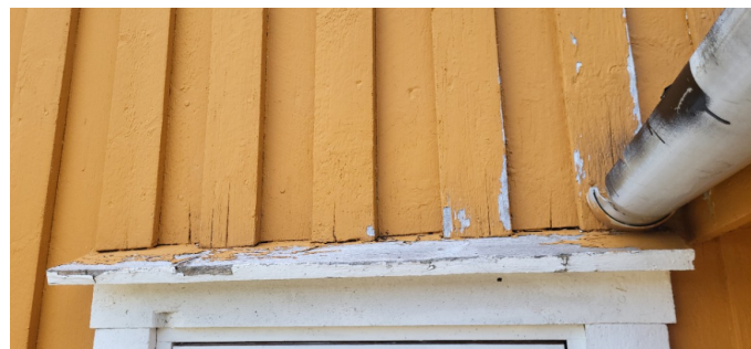
Kledning er satt helt ned på vannbrett.
