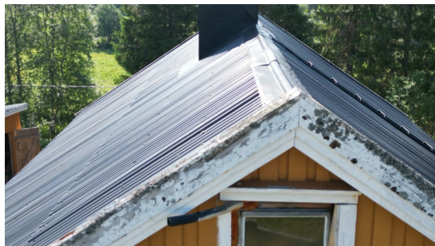
Ventilasjonsrør fra bad ut ved vindu.
