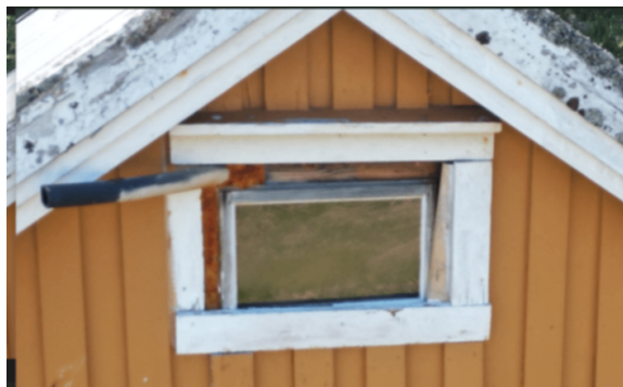
Vindu på kaldloft provisorisk innsatt.
