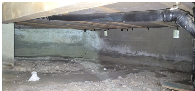
Ventilering gjennom vegger.
