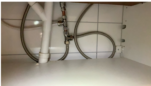
Kontroll av rørsystem
