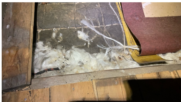
Isolering med sydde matter med glassull
