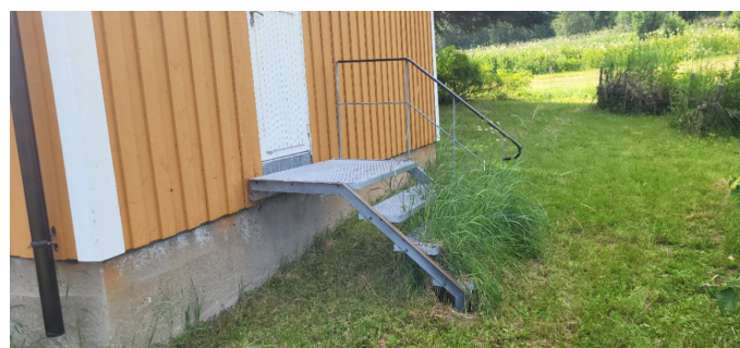
Trapp inn til bod i tilbygg.
