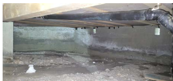
Ventilering gjennom vegger.
