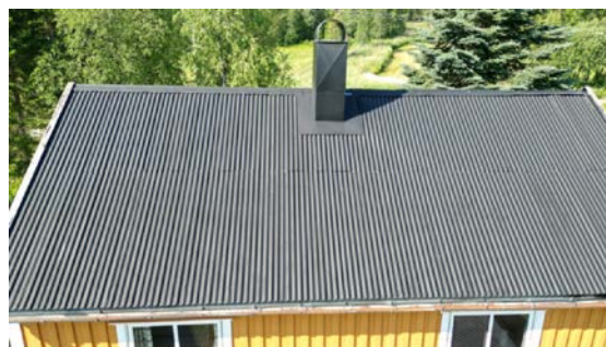
Bølgeblekk på hovedtak.
