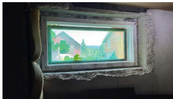
Vindu i kjeller.
