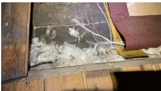
Isolering med sydde matter med glassull
