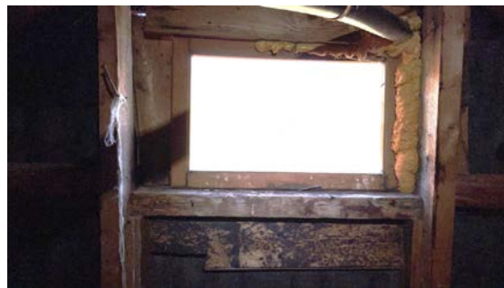
Vindu på kadloft.
