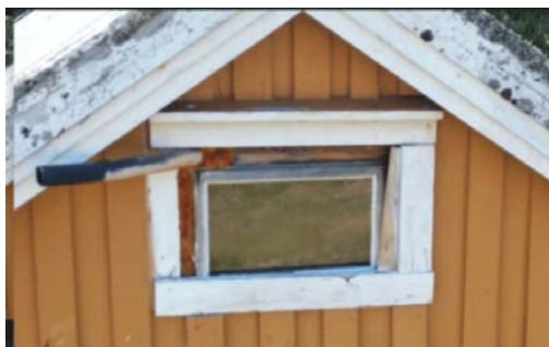
Vindu på kaldloft provisorisk innsatt.
