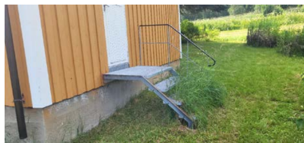
Trapp inn til bod i tilbygg.
