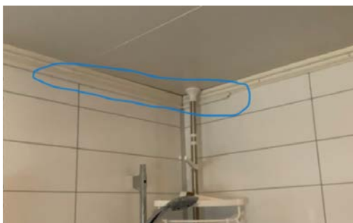
Åpne ledninger er ikke tillatt i dusj
