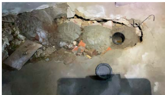
Plast i bunnledning under gulv i kjeller.
