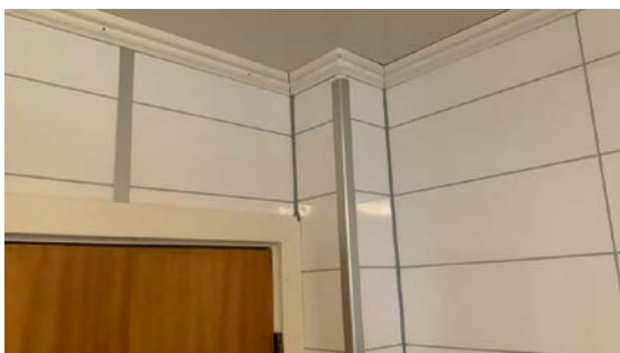
Innvendige hjørner er fuget.
