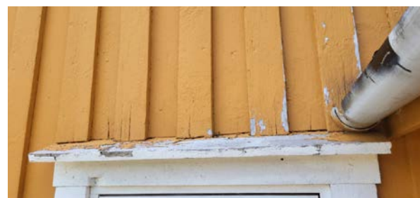
Kledning er satt helt ned på vannbrett.
