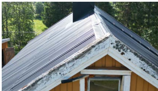
Ventilasjonsrør fra bad ut ved vindu.
