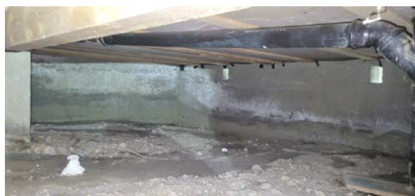
Ventilering gjennom vegg.
