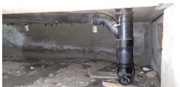
Salt på innvendige betongvegger.
