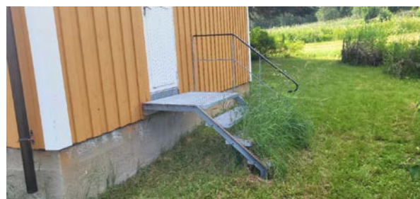
Trapp inn til bod i tilbygg.
