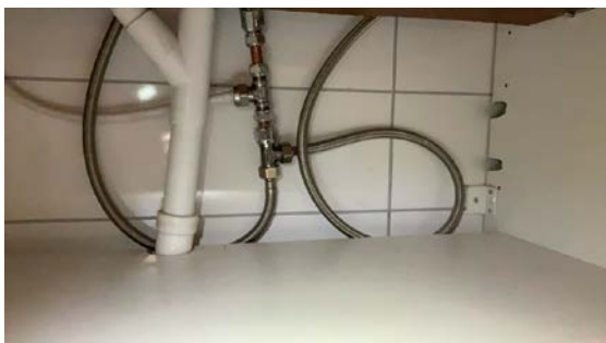
Kontroll av rørsystem
