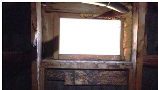
Vindu på kadloft.
