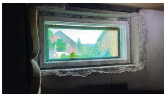
Vindu i kjeller.
