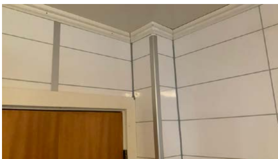
Innvendige hjørner er fuget.
