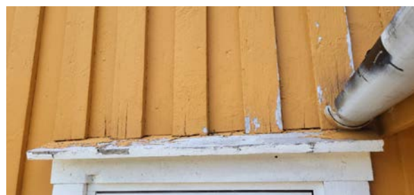
Kledning er satt helt ned på vannbrett.
