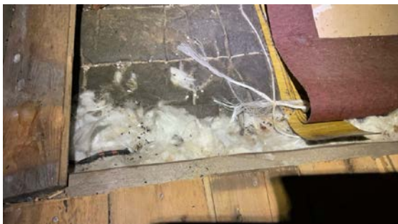
Isolering med sydde matter med glassull
