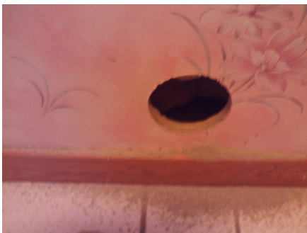
Hulltaking i vegg mot bad.
