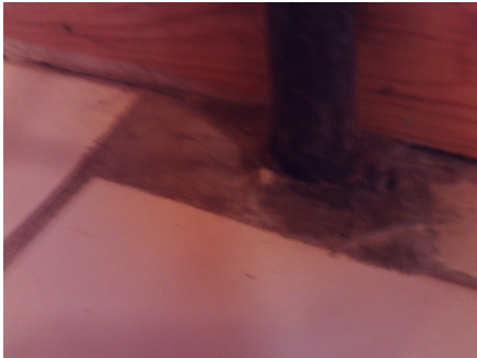
Rørgjennomføring i gulvet
