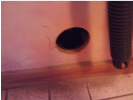
Hulltaking i utfored vegg på vaskerommet
