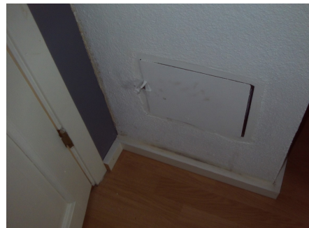
Sotluke på ene soverommet.
