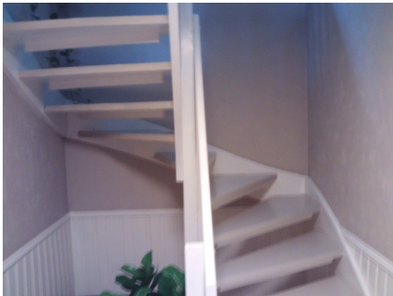
Trapp mellom etasjer.
