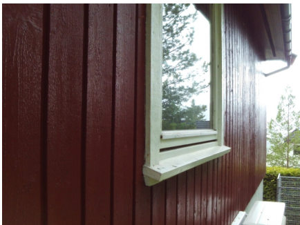
Deler av kledningen med tilhørende belistninger.
