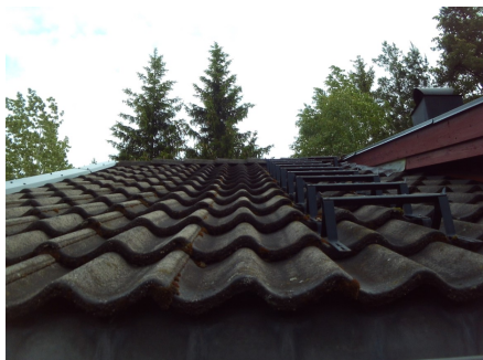
Deler av taktekkingen.
