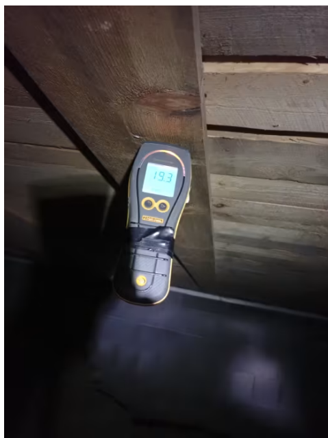
Fuktmåling i treverk i kryprom.
