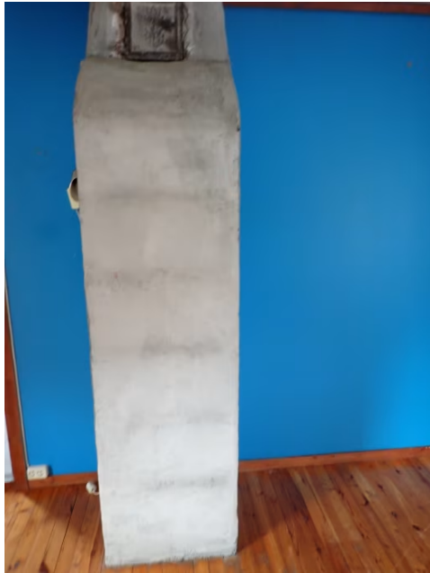
Pipe gjennom soverom 1 er av element og teglstein.
