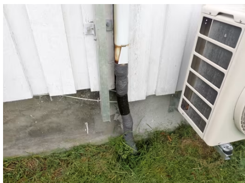
Midlertidig løsning med nedløp til grunnen.
