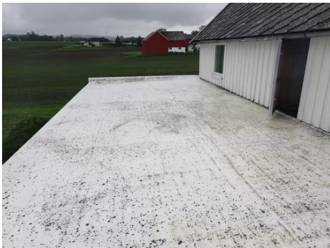
Taktekking av glassfiber.
