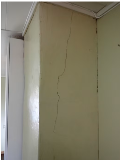
Pipe gjennom soverom 3 er av teglstein.
