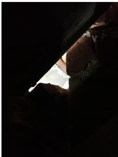
Åpning mellom beslag og takteking på kaldtloft over soverom 1.
