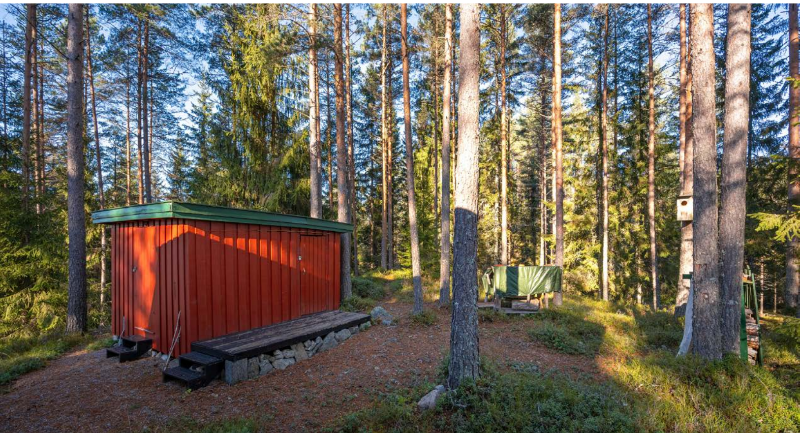
I et frittliggende uthus på ca. 12 kvm er det to boder og en utedo.
