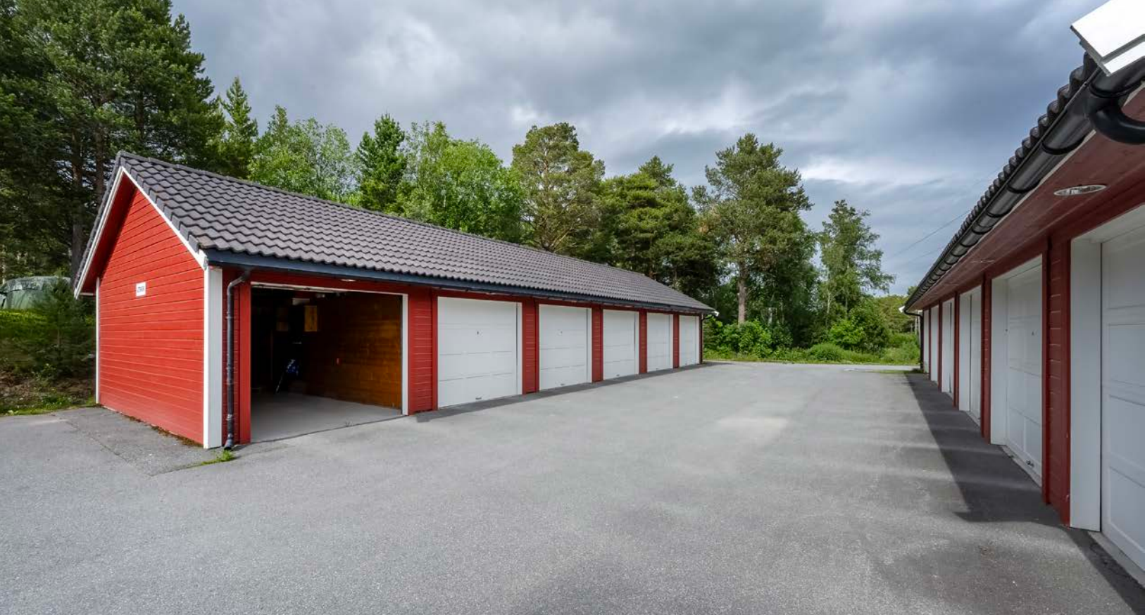
Garasje i felles garasjerekke, utstyrt med leddport med motorisert åpner
