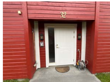
Ytterdør inn til bygget.
