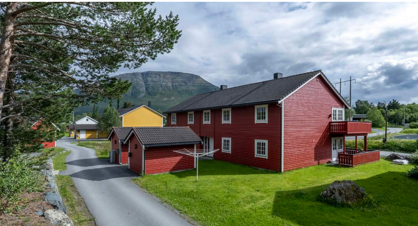
Fasade med inngangsparti og utvendige boder
