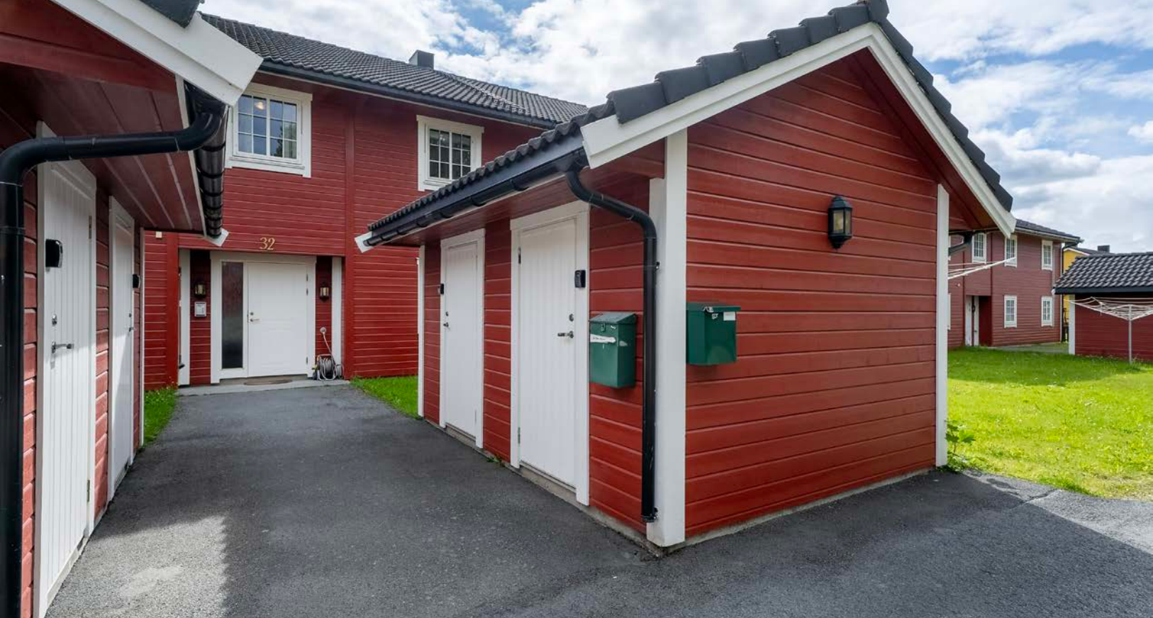
Praktisk utvendig bod tilhørende leiligheten i tilknytning til inngangspartiet
