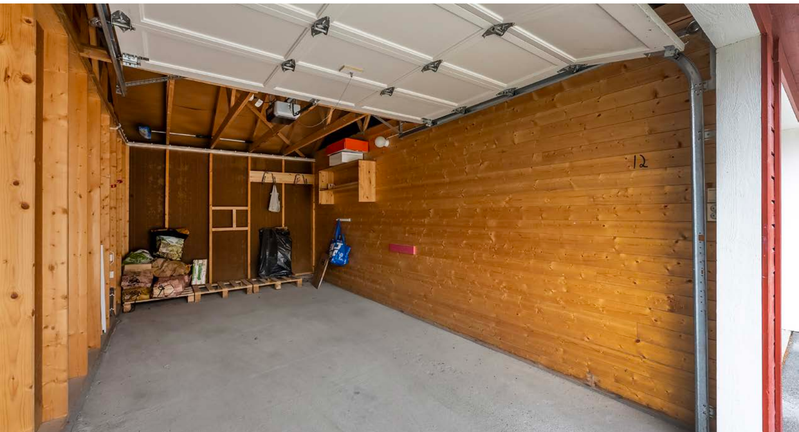
Garasjerom på ca. 17 m 2
