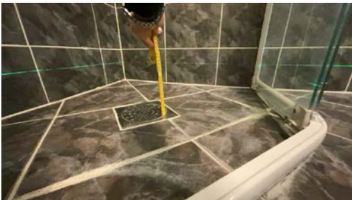
Målt topp slukrist
