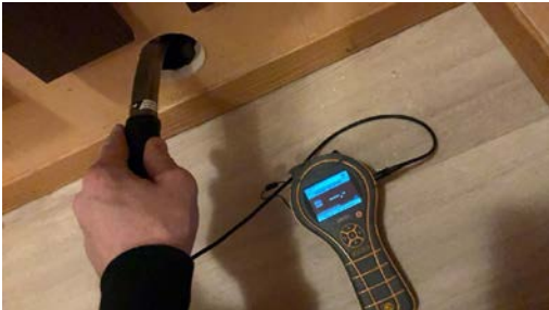
Ingen fuktutslag registrert ved fuktmåling i vegg
