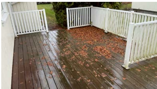
Løst rekkverk, samt vedlikeholdsbeho
