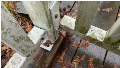
Løst rekkverk, samt vedlikeholdsbeho
