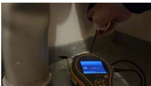
Ingen fuktutslag registret ved fuktmåling i vegg
