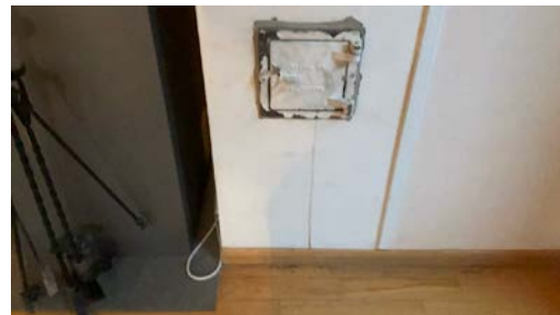
Rennemerke, samt manglende plate på gulvet
