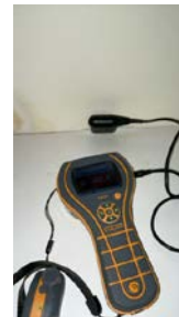
Målt fuktighet i svelling i skap under vask
