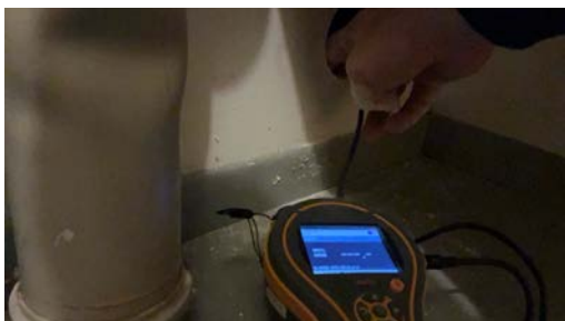
Ingen fuktutslag registret ved fuktmåling i vegg
