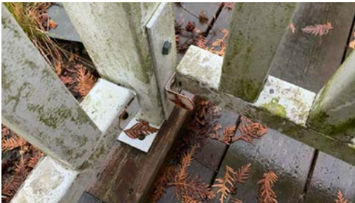
Løst rekkverk, samt vedlikeholdsbeho
