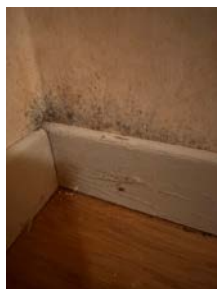
Muggsopp/svertesopp i hjørnet på ett av soverommene
