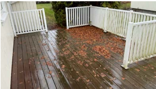
Løst rekkverk, samt vedlikeholdsbeho
