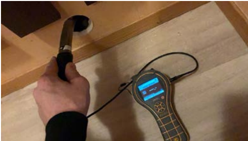
Ingen fuktutslag registrert ved fuktmåling i vegg
