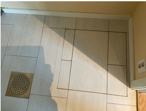
Plassering av luft aggregat i gulv, leilighet
