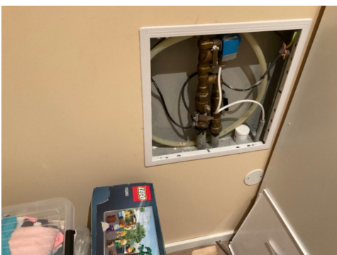
Rør i rør skap i 2. etasje
