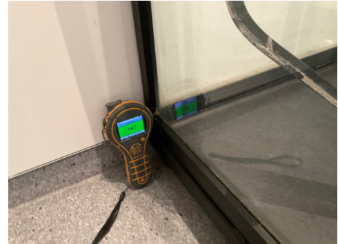
Måling ved dusjkabinett
