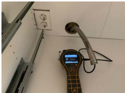
Hulltaking i garderobe, bad 2. etasje
