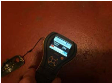
Det ble registrert lokale forhøyede fuktverdier ved stikkprøvekontroll i gulv i kjeller. Her fra uisolert matbod.
