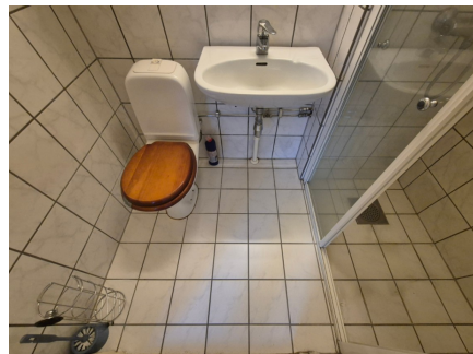
Gulv med overflater av fliser
