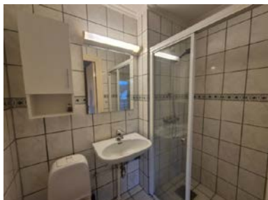
Vegger med overflater av fliser.
