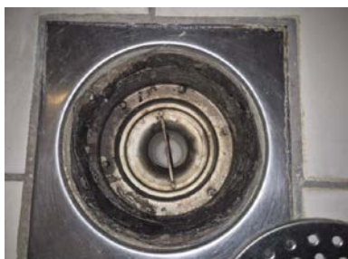
Utettheter rundt sluken.
