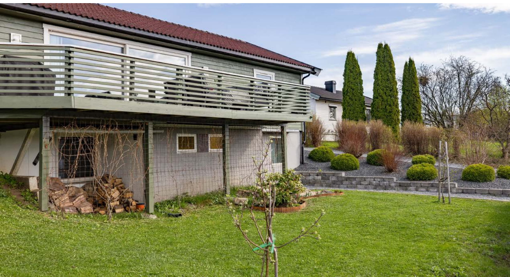
Ryddig og pent opparbeidet hageanlegg opparbeidet med plen og variert beplantning. Forstøtningsmur av lettklinkerblokker ved inngang til underetasje.
