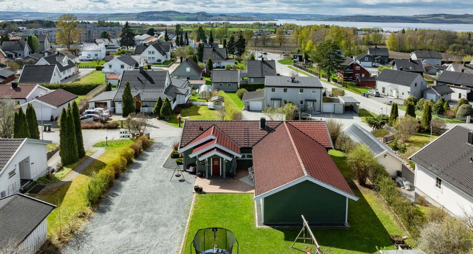
Boligen har taktekking fra 2012 og 2001, samt yttervegger kledd med liggende panel som ble overflatebehandlet i 2023 med to strøk.
