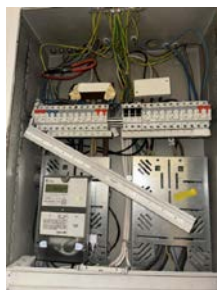
Sikringsskap med automatsikringer. Manglende deksel rundt sikringer.
