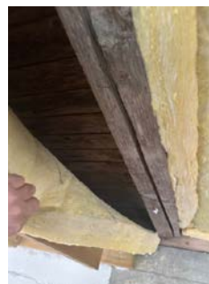
Isolasjon i bjelkelag under terrasse
