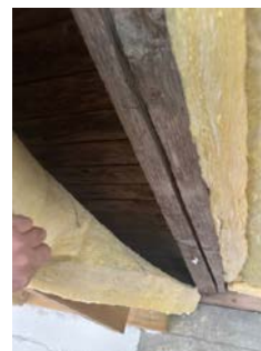
Isolasjon i bjelkelag under terrasse
