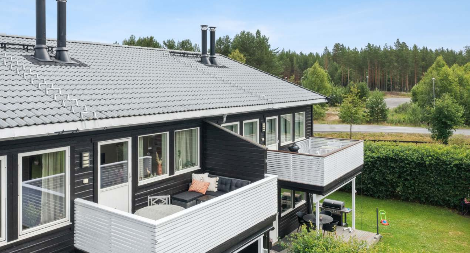
Fin og solrik beliggenhet i byggets 2. etasje og mot syd.
