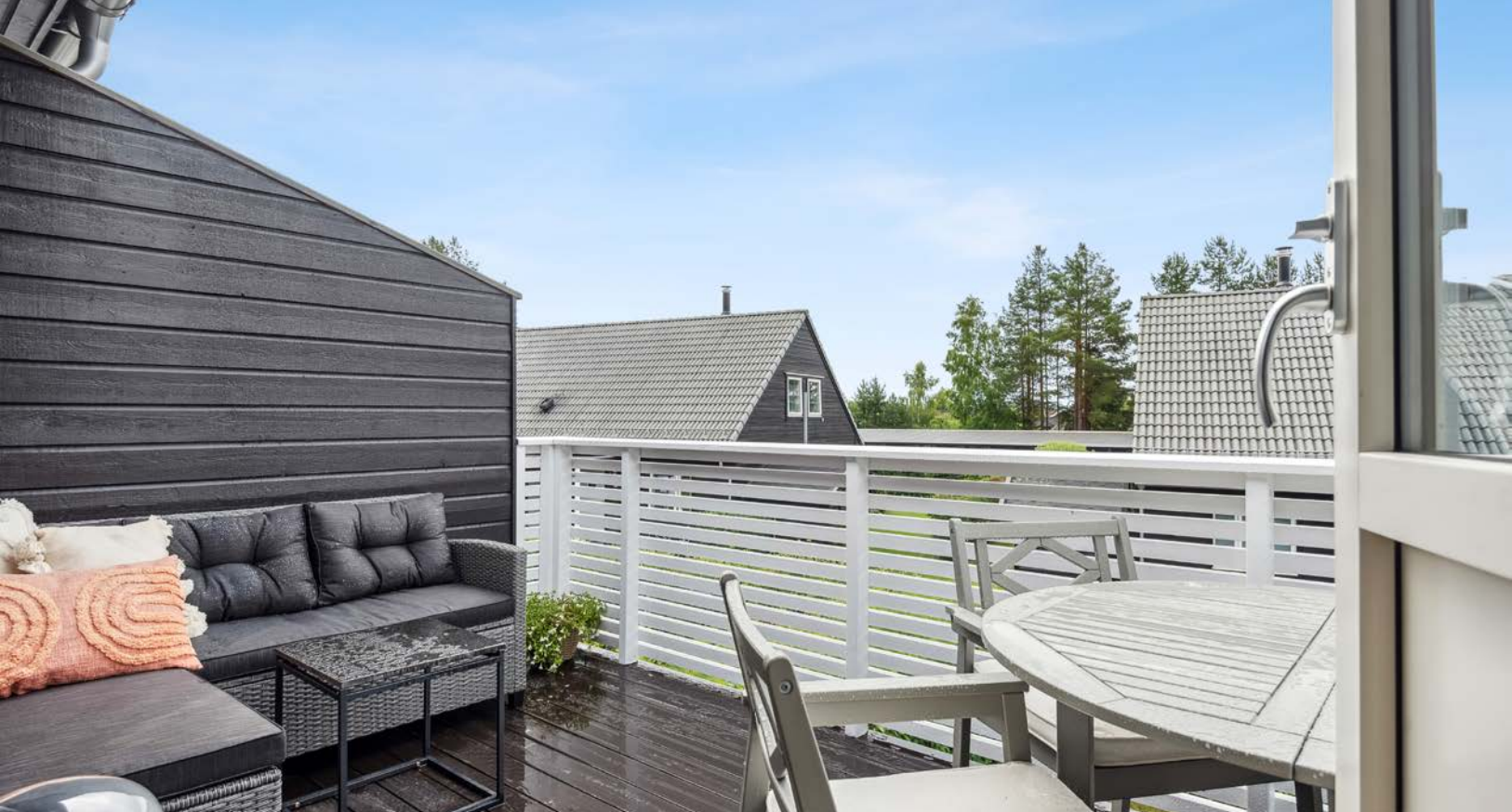
Balkongen har impregnerte terrassebord på gulv, beiset- malt rekkverk og levegg mot naboen.
