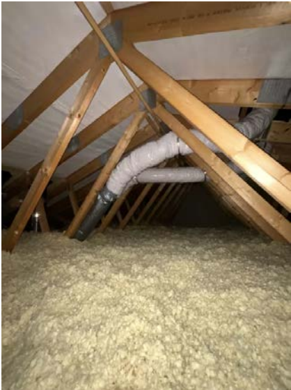
Fabrikkerte w-takstoler. Undertak med duk.
