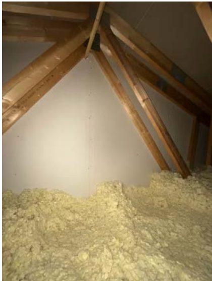
Himling isolert med blåseull. Gips som brannskille mot naboelighet.
