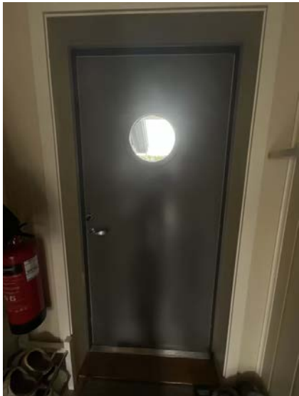
Brannklassifisert ytterdør med glassfelt.
