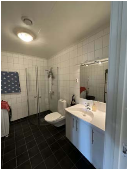
Viser baderomsinnredning, dusjhjørne med foldevegger i glass og vegghengt toalett med innebygget sistene.
