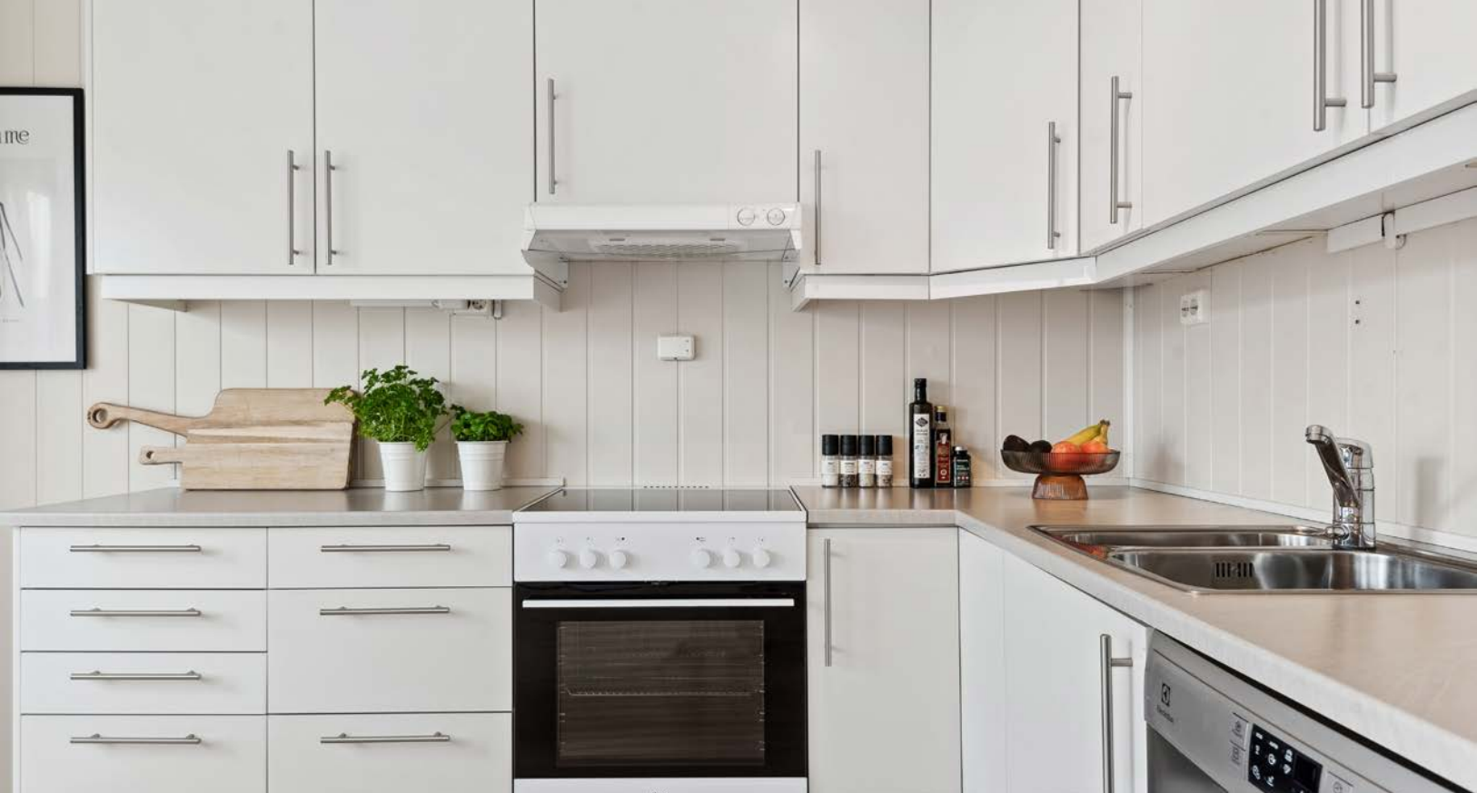
Kjøkkenet er utstyrt med mekanisk avtrekksvifte, komfyrvakt og vannstoppeventil i benkeskap.
