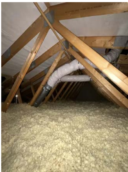
Fabrikkerte w-takstoler. Undertak med duk.
