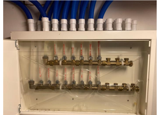
Rør i rør skap.
