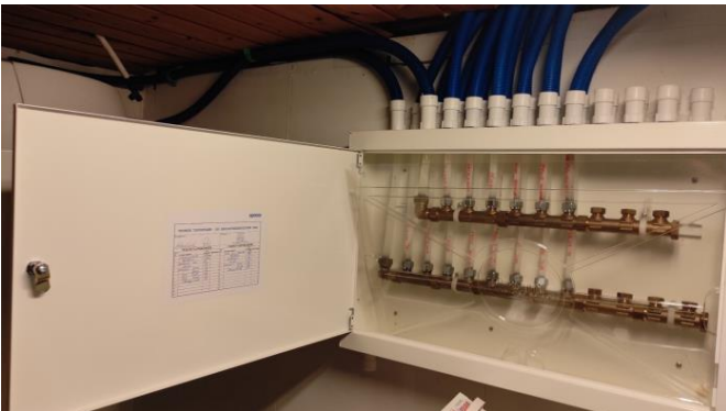
Kontroll av rørskapet.
