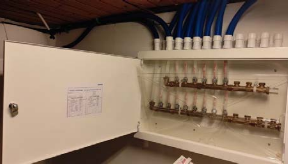
Kontroll av rørskapet.
