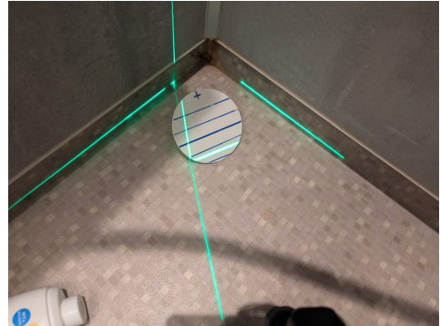
Måling av lokalt fall mot sluk
