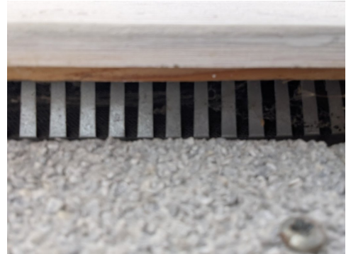
Underkant av kledning
