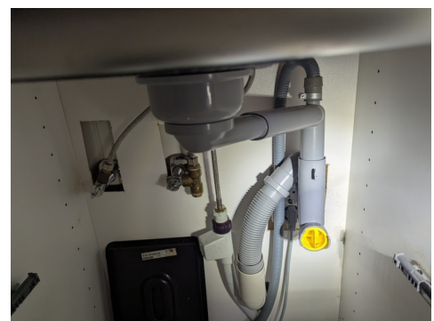
Avløpsrør i kjøkkenbenk
