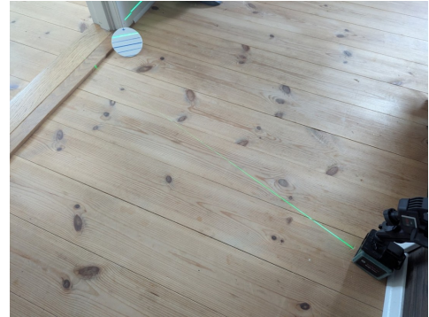
Måling av skjevhet/retningsavvik på gulv i loftplan
